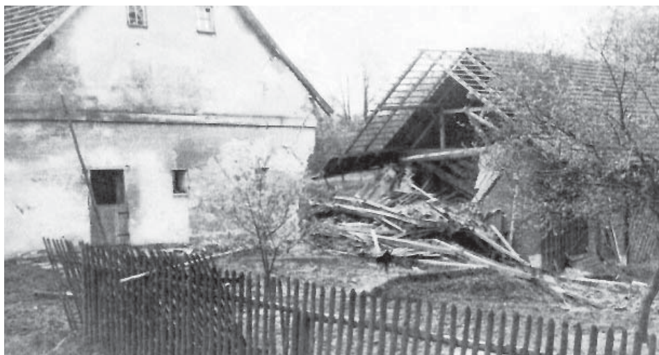
Stodola usedlosti pana Lýska č.p. 2 na Mitrovické ulici. Dnes její obytnou část přestavuje pan Buček.
