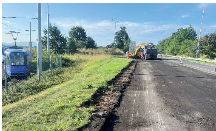
Provoz na Plzeňské v druhé polovině prázdnin limitovaly opravy.
