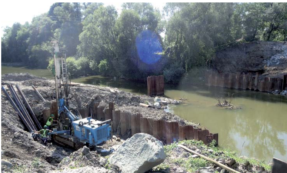
Stavba nového mostu přes Odru hlásí komplikace. Konečný termín se odkládá.
