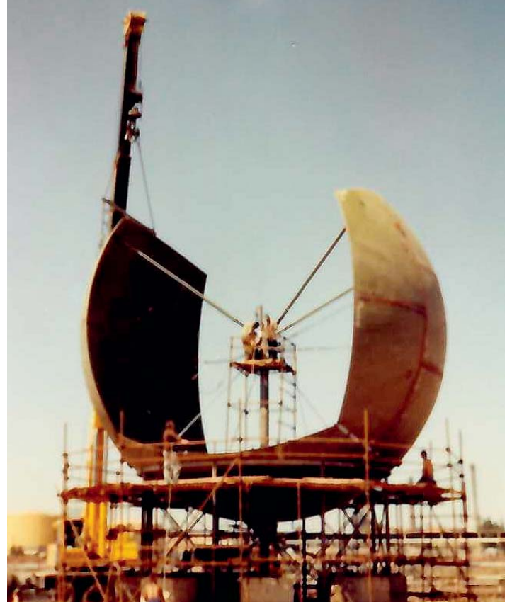
Hutní montáže měly v Sýrii smontovat dvě kulové tlakové nádoby na zkvapalněný propan-butan.
