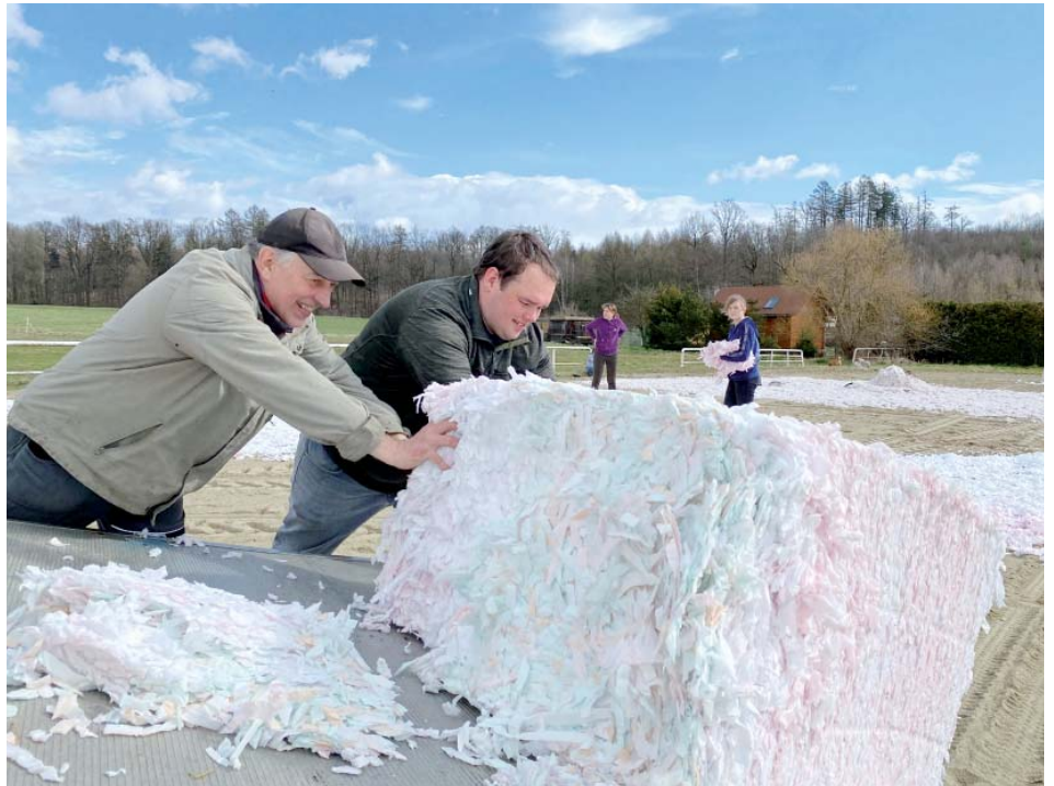
Pavel a Jan Hudečkoví rozmisťují geotextilní materiál.
