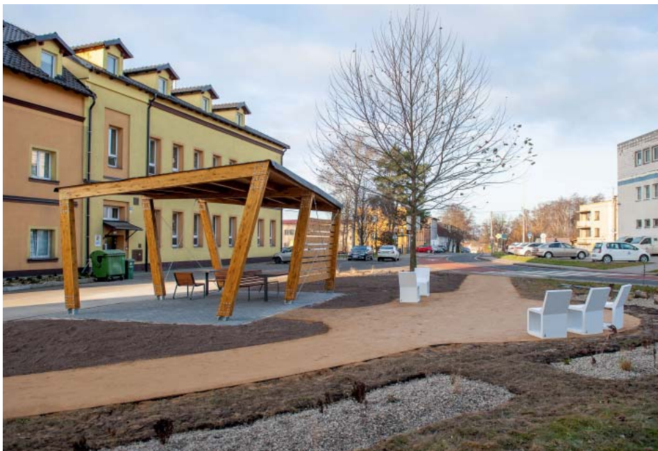
Přístřešek je hotový. Od jara se ještě začnou zelenat osázené plochy. Foto: Martin Grobař.
