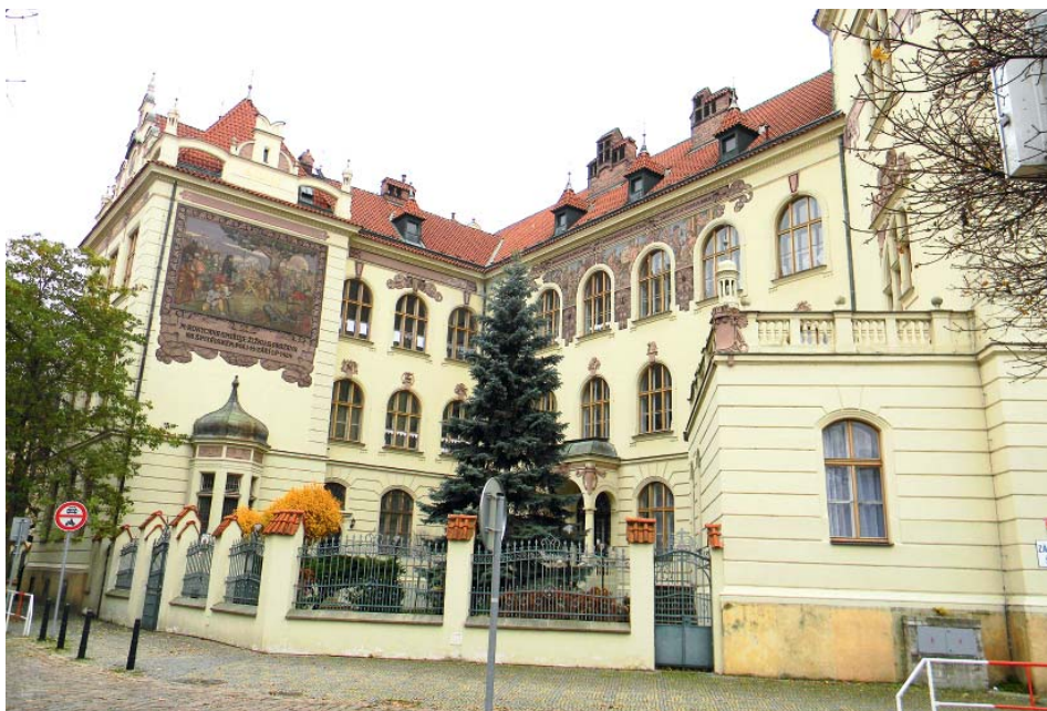
Secesní budova Základní školy Lyčkovo náměstí v Praze-Karlíně.
