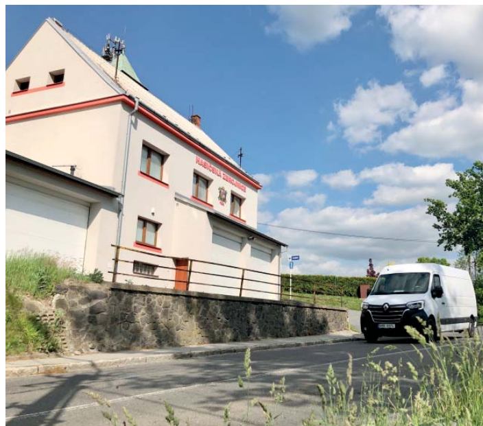
Pod částí silnice se postupně bude měnit potrubí.
