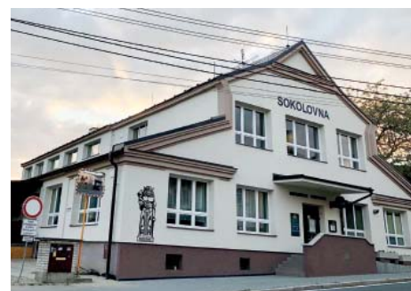
Restaurace obývá část přízemí.
