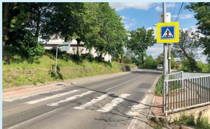
Rozkopanými úseky se bude jezdit podle semaforu.
