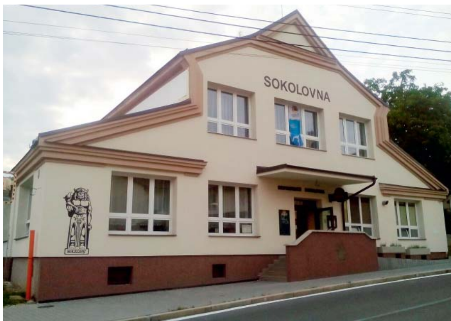
Tělocvična Sokolů má nový plášť, střechu i okna.
