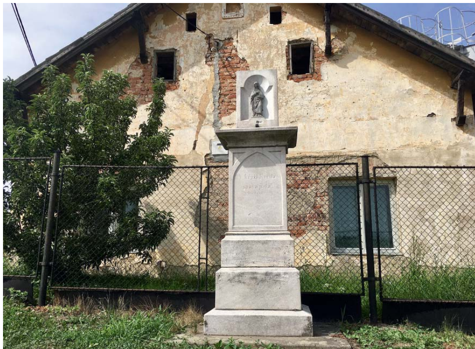
Pískovcový podstavec čekající na opravený kříž, červen 2019.
