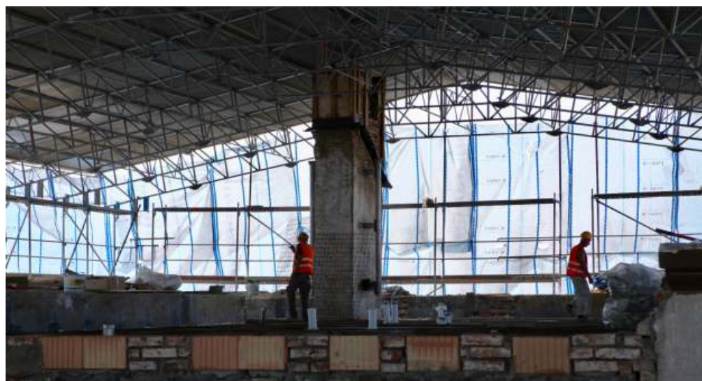
O prázdninách se pracovalo pod provizorní střechou.
