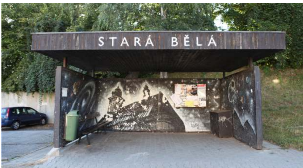
Bytelné zděné přístřešky postupně zmizí.
