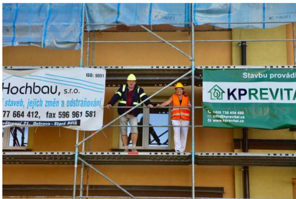
Na zakázce spolupracují dvě starobělské stavební firmy: Hochbau a KP Revital.
