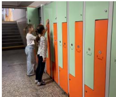
Do šaten v základní škole při větších deštích zatéká. Dočkají se obnovy.
