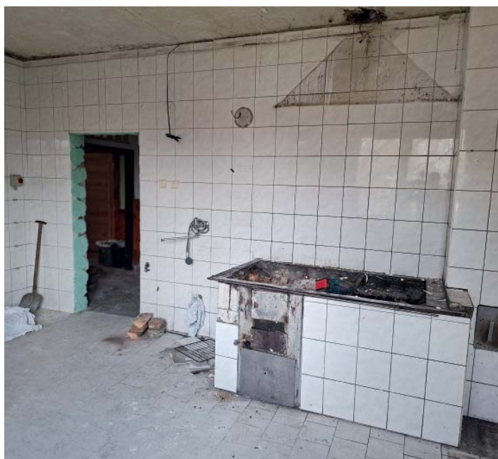
Před opravou. V kuchyni do té doby využívali kamna na uhlí.
